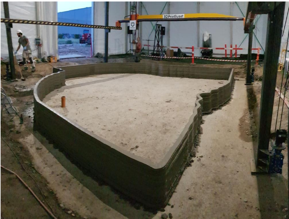
Status efter første dags print af The BOD, den 11. september 2017
