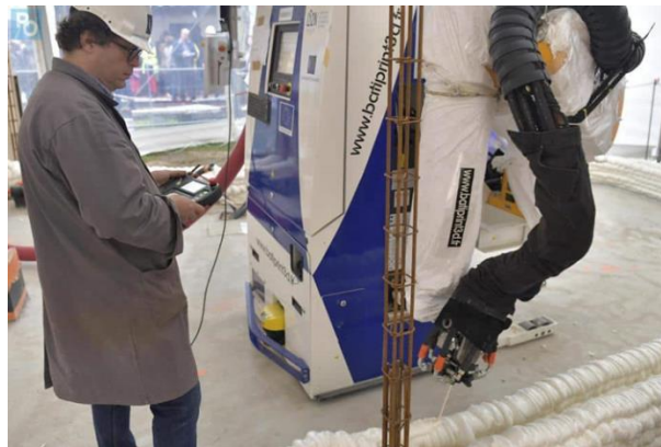
Yhnova bygningen under dets opførelse (Nantes Universitet)
