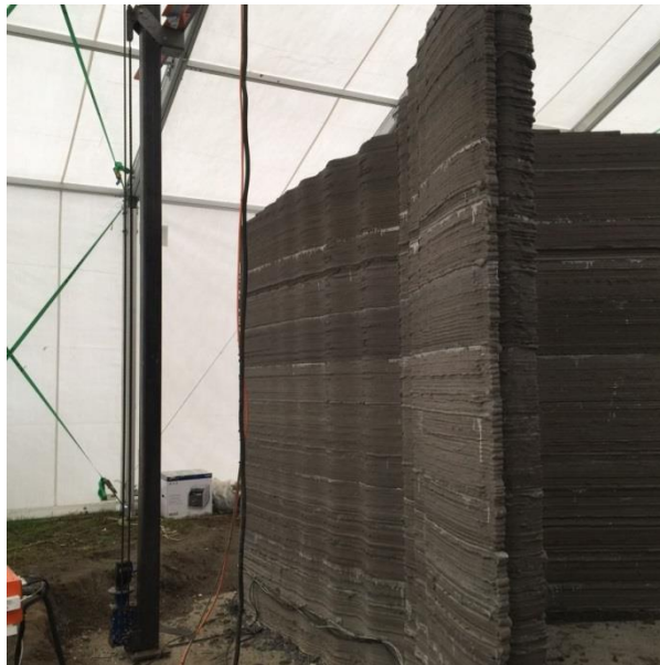
Færdige 3D printede vægge på The BOD. Ensartet/glatheden af printet kunne være bedre
