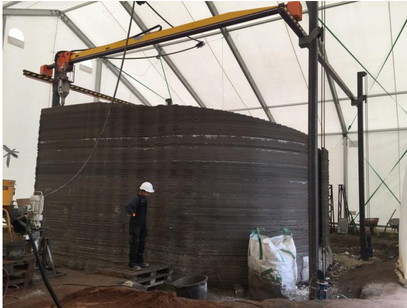
Færdige 3D printede vægge medio november 2017. Bemærk taghældningen.
